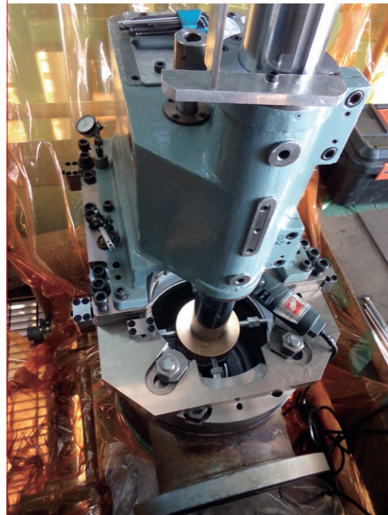
現地での弁座交換作業
