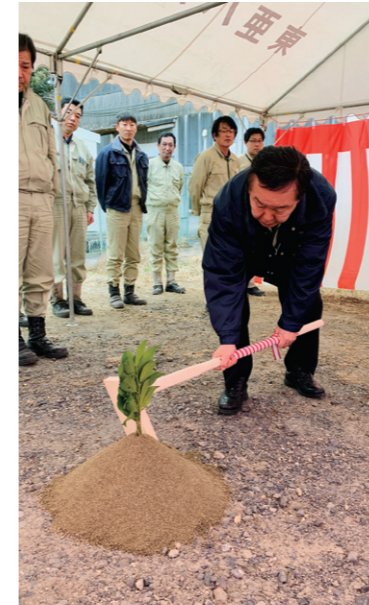
伊賀工場特高受電所起工式で鉄入れをする笹野社長(2022年2月)
