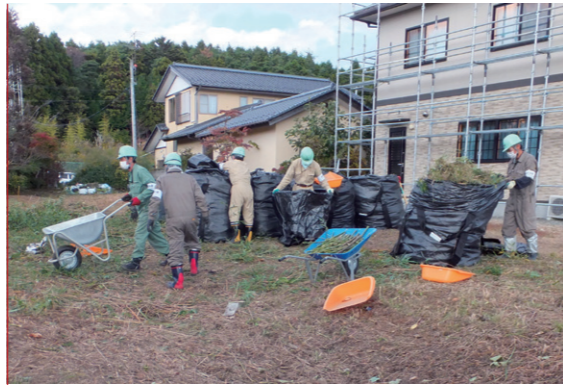
福島県内での地域除染作業
